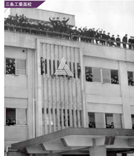
校章が一棟正面に完成(昭和46年)
