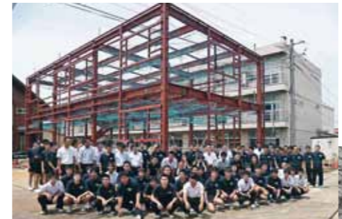
上棟式(平成25年)
