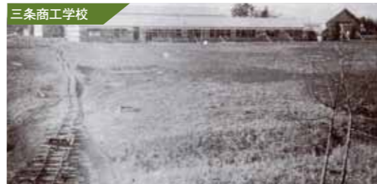
工事中の新校舎(昭和18年)
