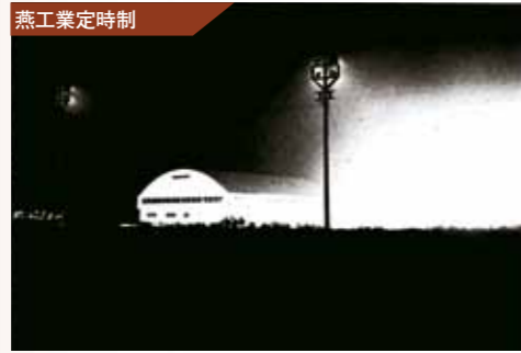
燕工業定時制夜間照明完成(昭和45年)
