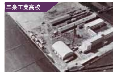
9月建設中の校舎(昭和39年)
