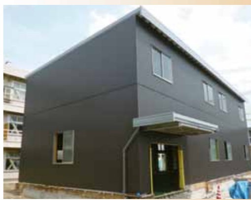
外観ほぼ完成のトレーニング場(平成25年)
